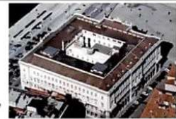
1999-2007 PALAZZO DEL LLOYD TRIESTINO Tetto in rame e zinco istano della nuova sede della Regione FVG in Piazza Unità d'Italia.
