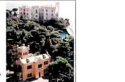
2000 CASTELLETTO DI MIRAMARE Nuova sede del WWF nel comprensorio del Castello di Miramare. Copertura in metallo modificato.
