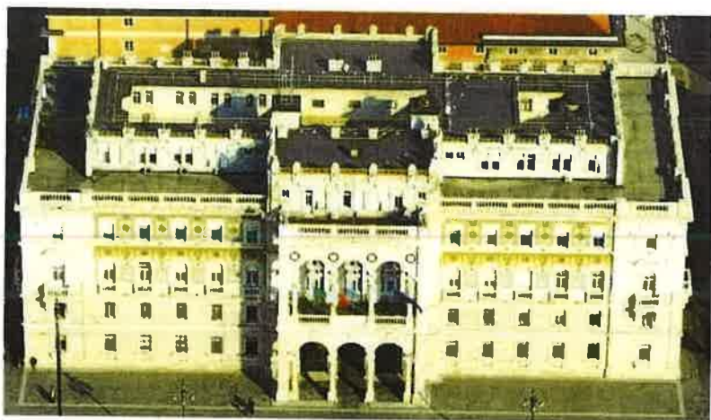
Prefettura di Trieste. Copertura terrazze ed impermeabilizzazioni del piano terreno del palazzo palificato sul mare di Piazza Unità d'Italia.
